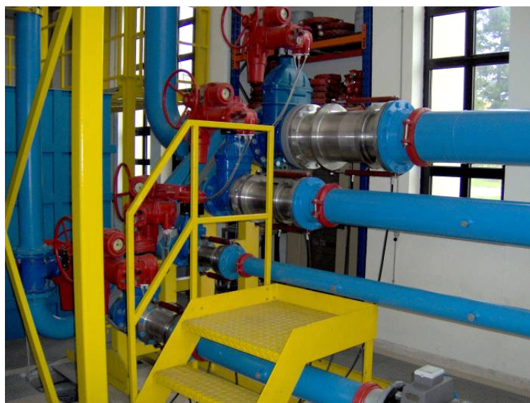
Figura 2.13 – Juntas telescópicas
