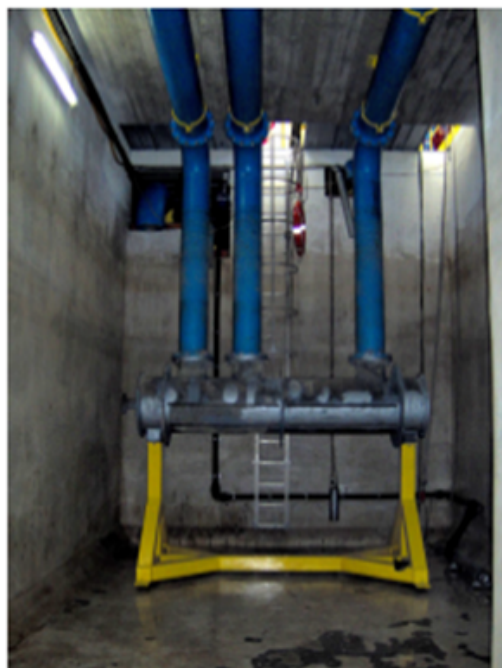
Figura 2.10 – Sistema de filtração
