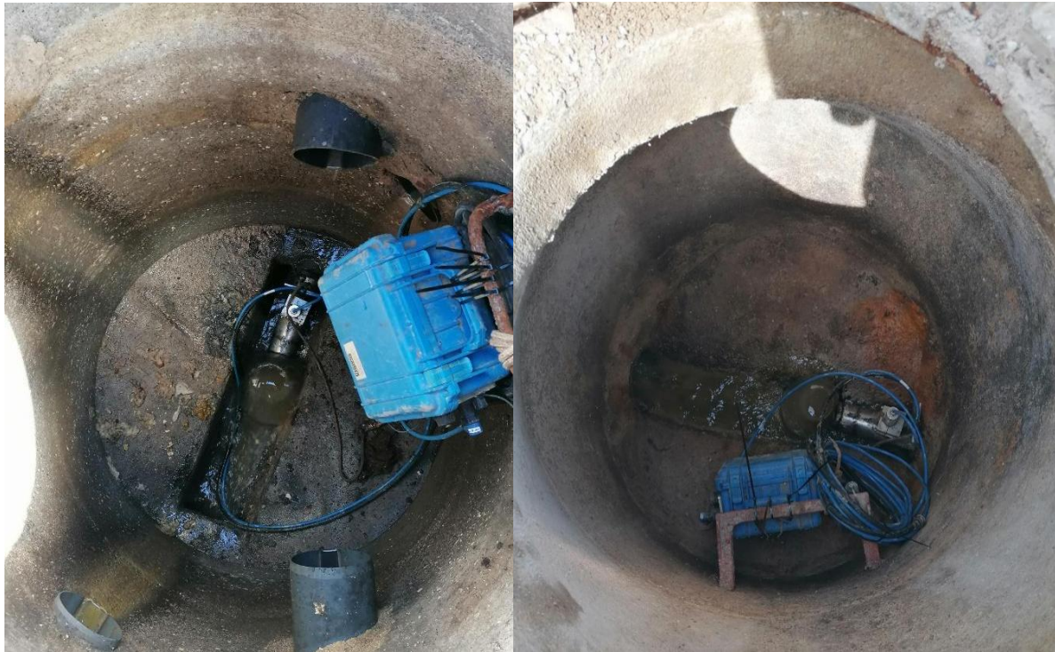
Figuras 3 e 4 – Utilização de equipamento de medição de escoamento em coletor, com caudal em contínuo, medidor de inserção tipo “Cachimbo”
